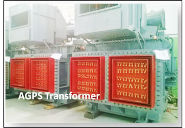
चित्र B.2.8 आयन साइक्लोट्रॉन प्रोटोटाइप उच्च वोल्टता शक्ति आपूर्ति का ईटर प्रयोगशाला में सफलतापूर्वक कमीशन किया गया एवं 27/18kV के दोहरे उत्पादन के साथ 3MW शक्ति के लिए प्रदर्शित
