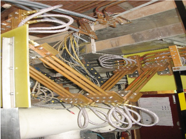
चित्र A.3.1.2 विकसित की गई उच्च विद्युत धारा लचीली लंबाई वाला फीड थ्रू। इसकी अवशोषण लंबाई > 1.2\text{m} है
